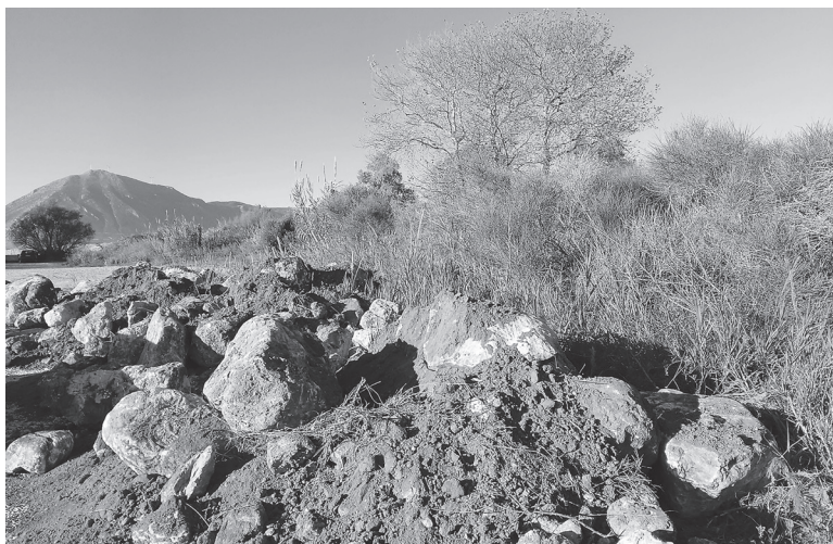
Πέτρες και χώμα έχουν μεταφερθεί στο πλατανόδασος για τις εργασίες
