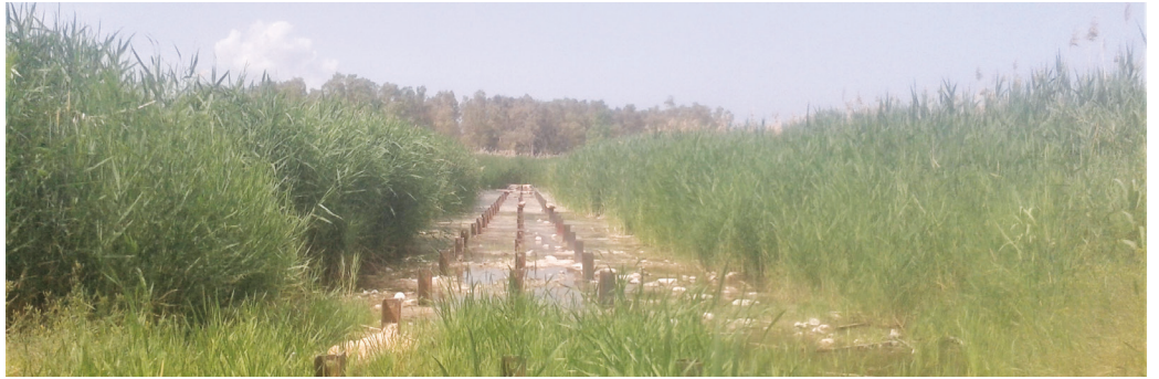
Άποψη της κατασκευής ξύλινου περιπατητικού διαδρόμου στο έλος Αγυιάς
