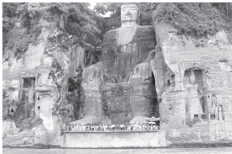
Μέσα στο άγαλμα του Βούδα του Leshan δημιουργήθηκε σύστημα-σφουγγάρι για αποστράγγιση νερού βροχής και μείωση διάβρωσης
