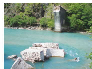
Απομεινάρια του γεφυριού μετά την κατάρρευση
