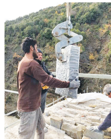
Εργασίες από την ανακατασκευή
