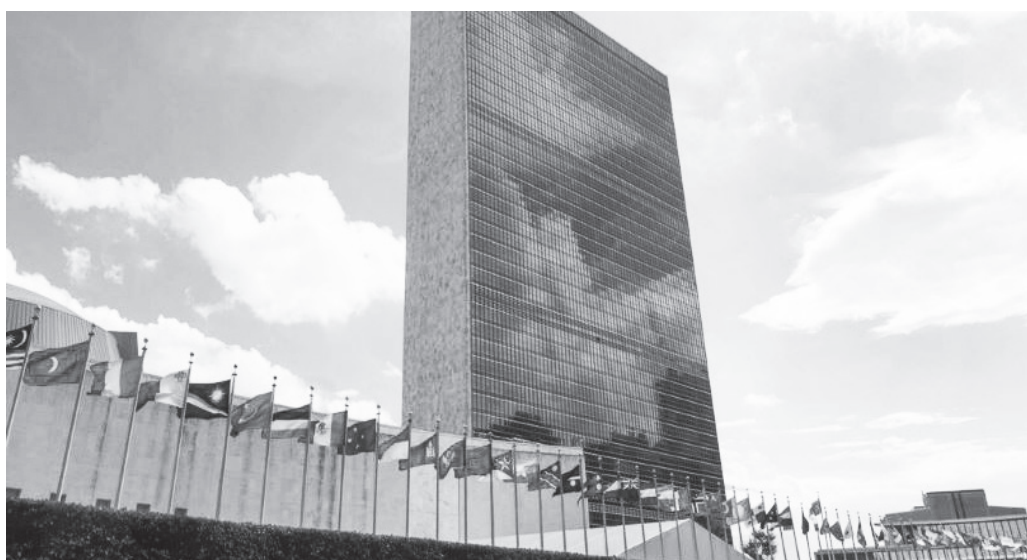
Στην οροφή της έδρας του ΟΗΕ εγκαταστάθηκαν 193 φωτοβολταϊκά πάνελ
