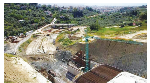
Άποψη των έργων στη μικρή περιμετρική
