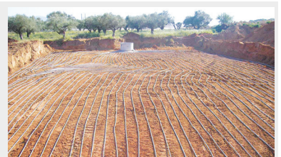
Γεωθερμικό σύστημα κλιματισμού σε ξενοδοχειακή μονάδα στο Ναυαρίνο της Μεσσηνίας
