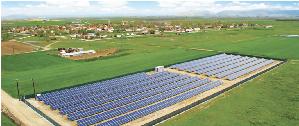
Φωτοβολταϊκό πάρκο 500 MW στο Γραμματικό Καρδίτσας
