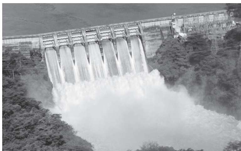
Υδροηλεκτρικό εργοστάσιο στην Κόστα Ρίκα
