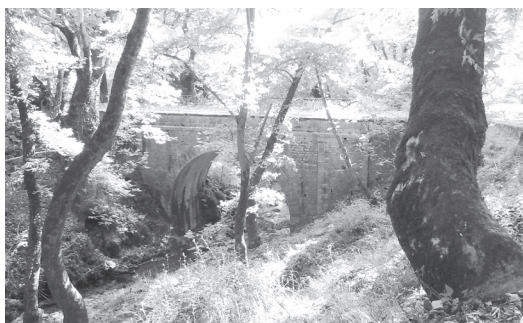
Γεφύρι στο Μοκιστιάνικο Ρέμα
