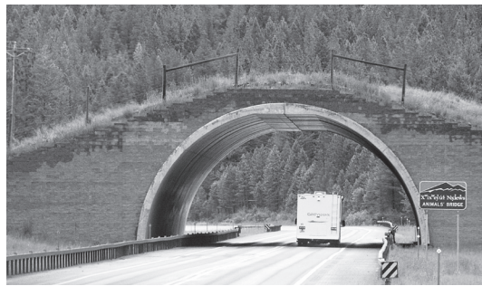
Ζωογέφυρα στον αυτοκινητόδρομο 93 της Μοντάνα των ΗΠΑ
