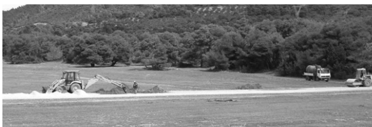
Αρχέλων - Κατασκευή του δρόμου
