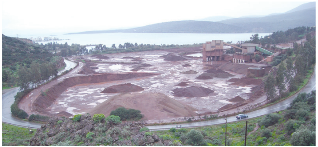
Γενική άποψη εγκαταστάσεων δίπλα στην εθνική οδό
