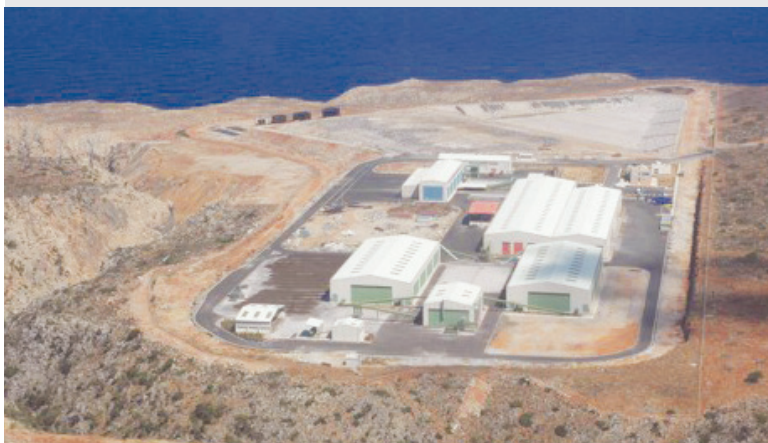
Μονάδα επεξεργασίας απορριμμάτων στα Χανιά
