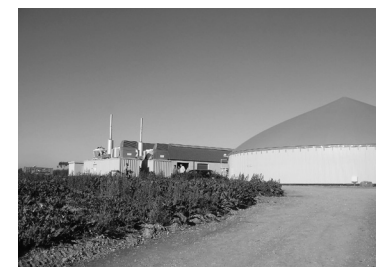
Μονάδα παραγωγής βιοαερίου στο Βέλγιο
