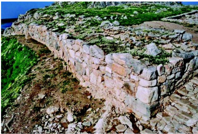
Αποψη τμήματος του τείχους
